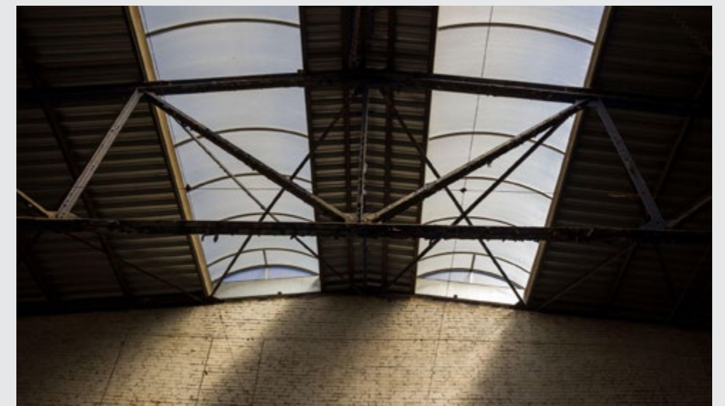
Widok na świetliki dachu hali i światło wnikające do wnętrza.
